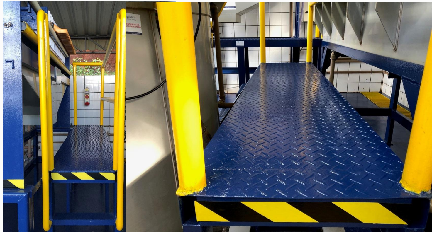
APÓS OS TRABALHOS
