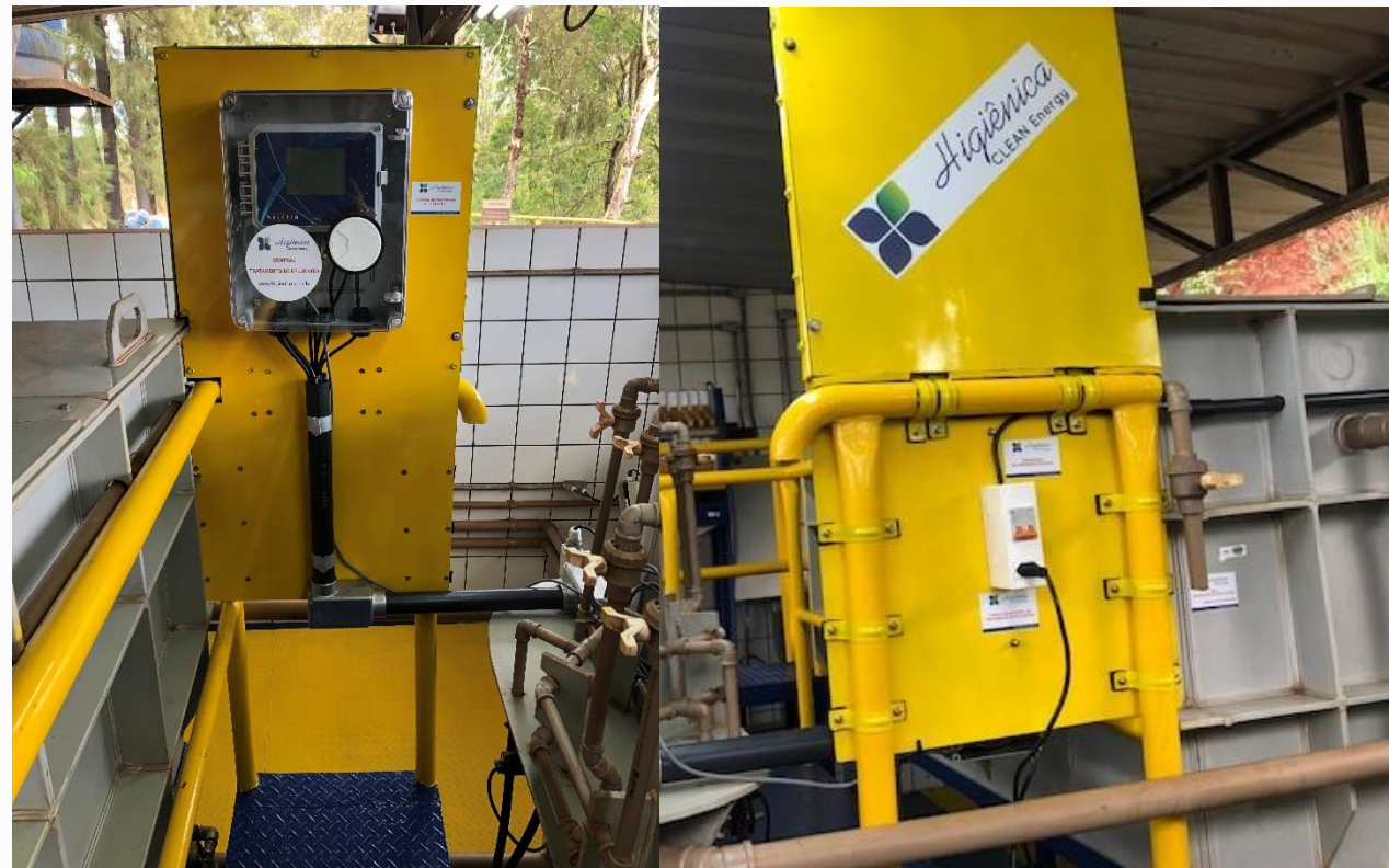
APÓS OS TRABALHOS
