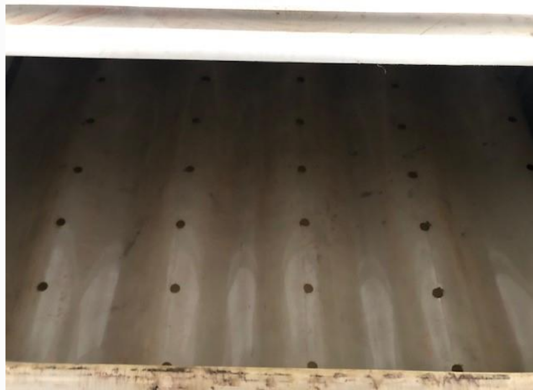
APÓS OS TRABALHOS
