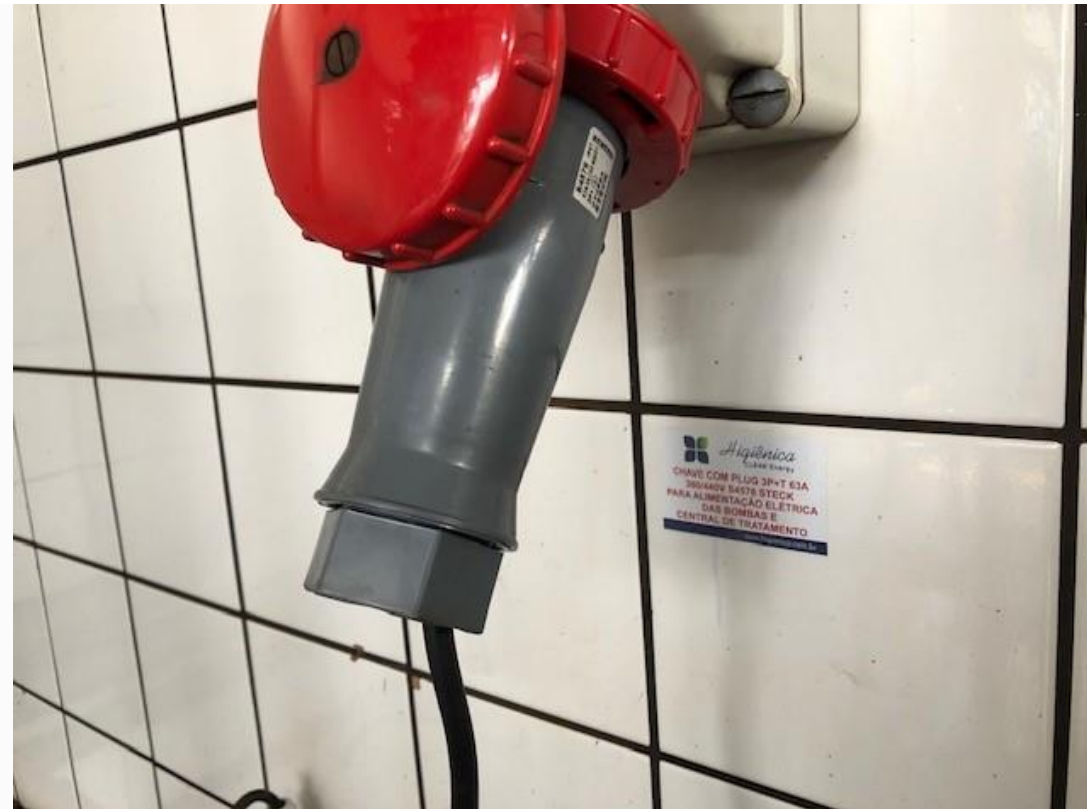
APÓS OS TRABALHOS
