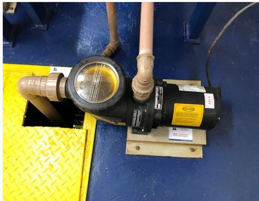
APÓS OS TRABALHOS
