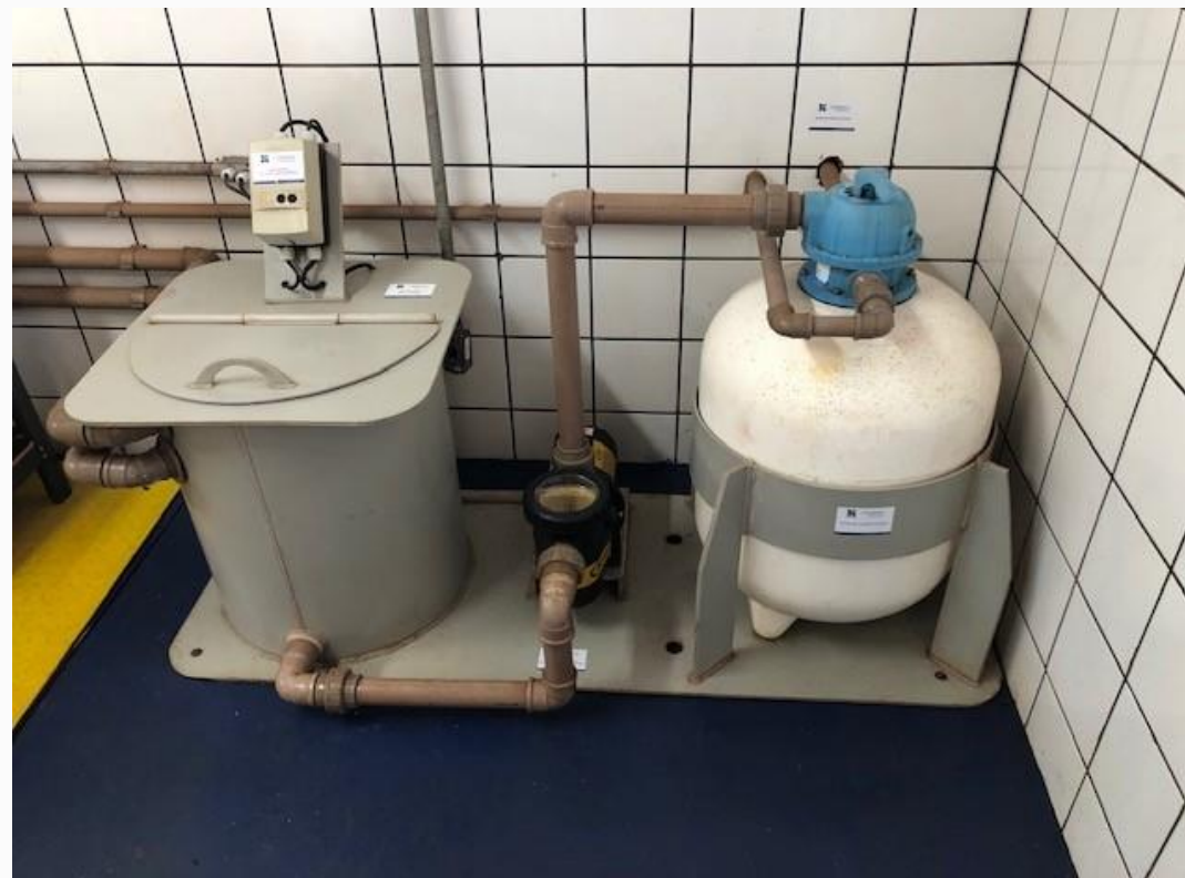
APÓS OS TRABALHOS
