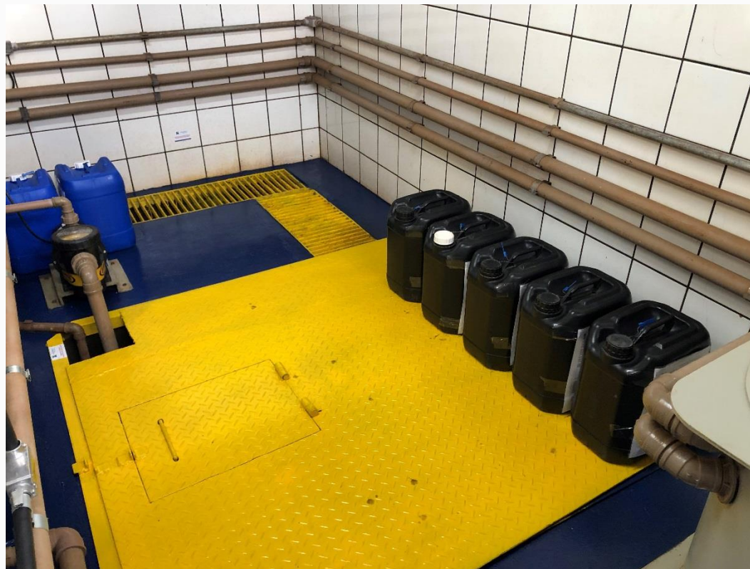
APÓS OS TRABALHOS
