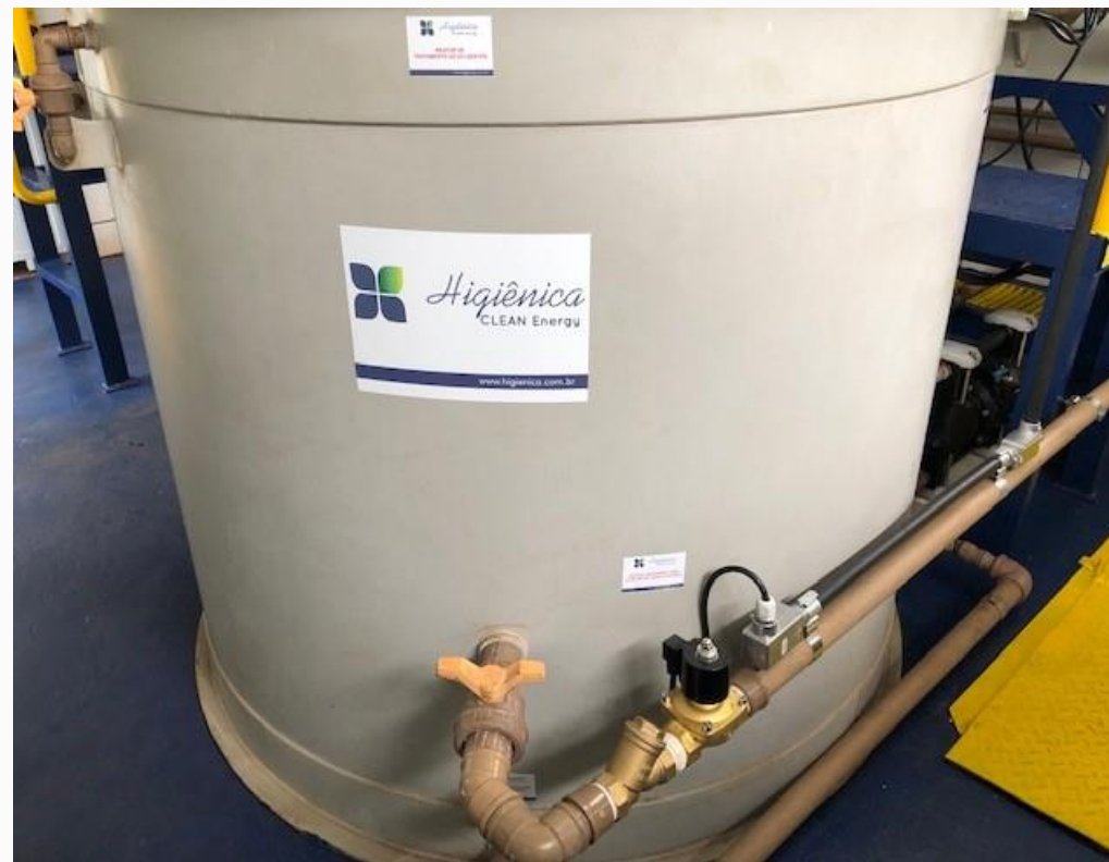
APÓS OS TRABALHOS
