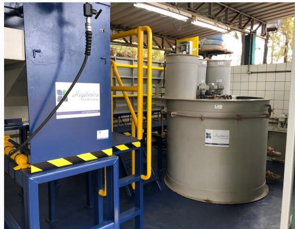
APÓS OS TRABALHOS
