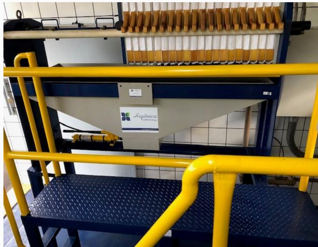
APÓS OS TRABALHOS
