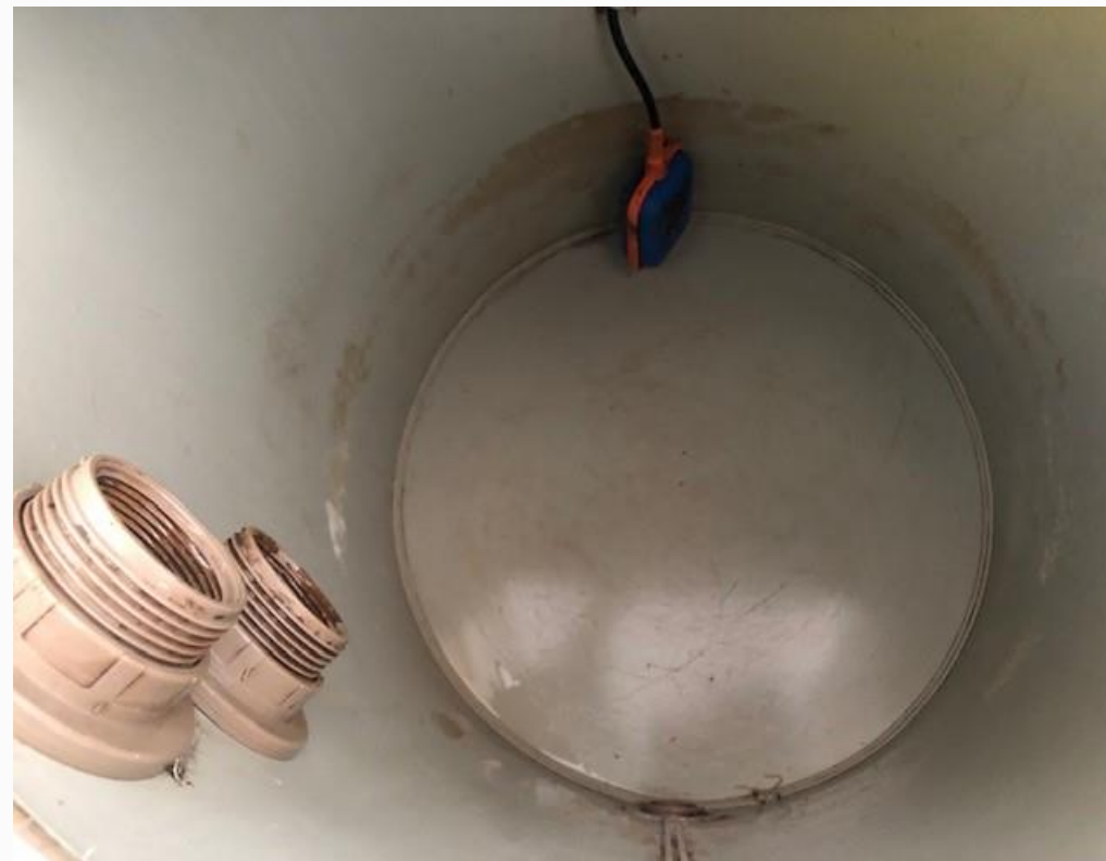
APÓS OS TRABALHOS
