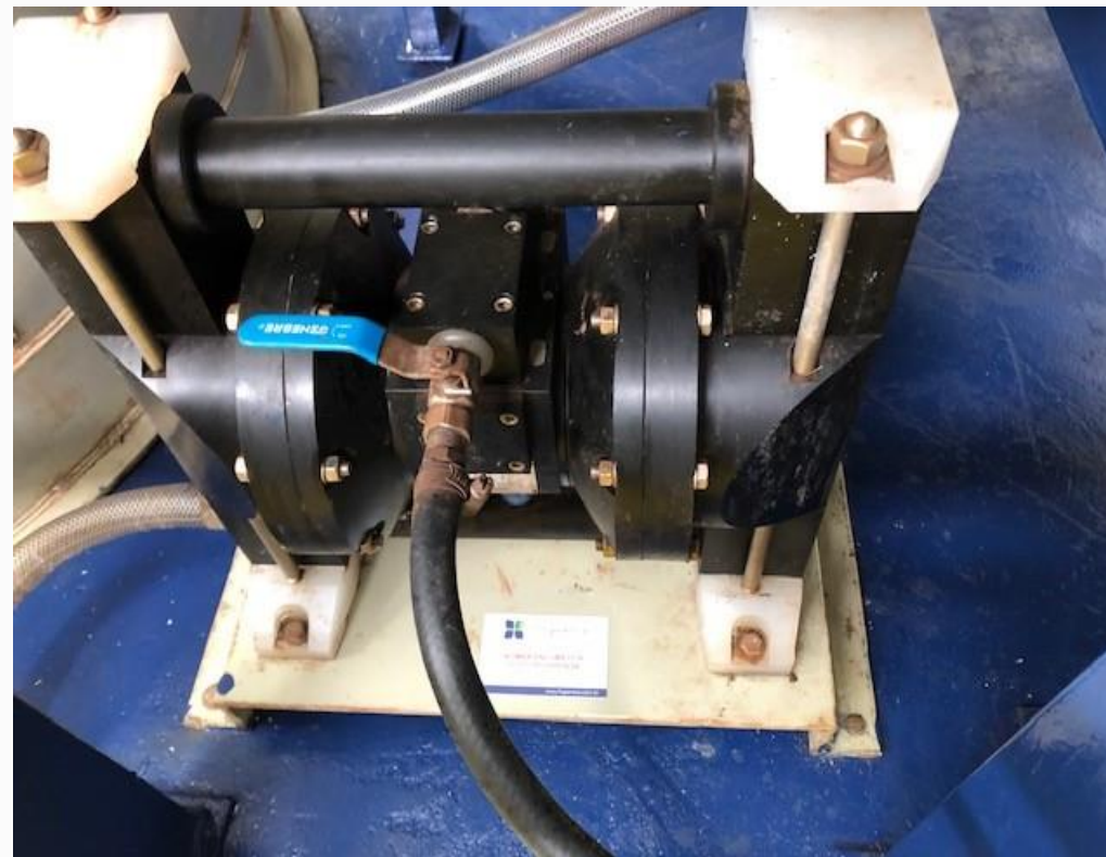
APÓS OS TRABALHOS
