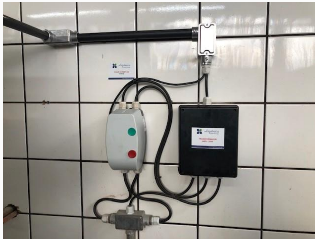
APÓS OS TRABALHOS
