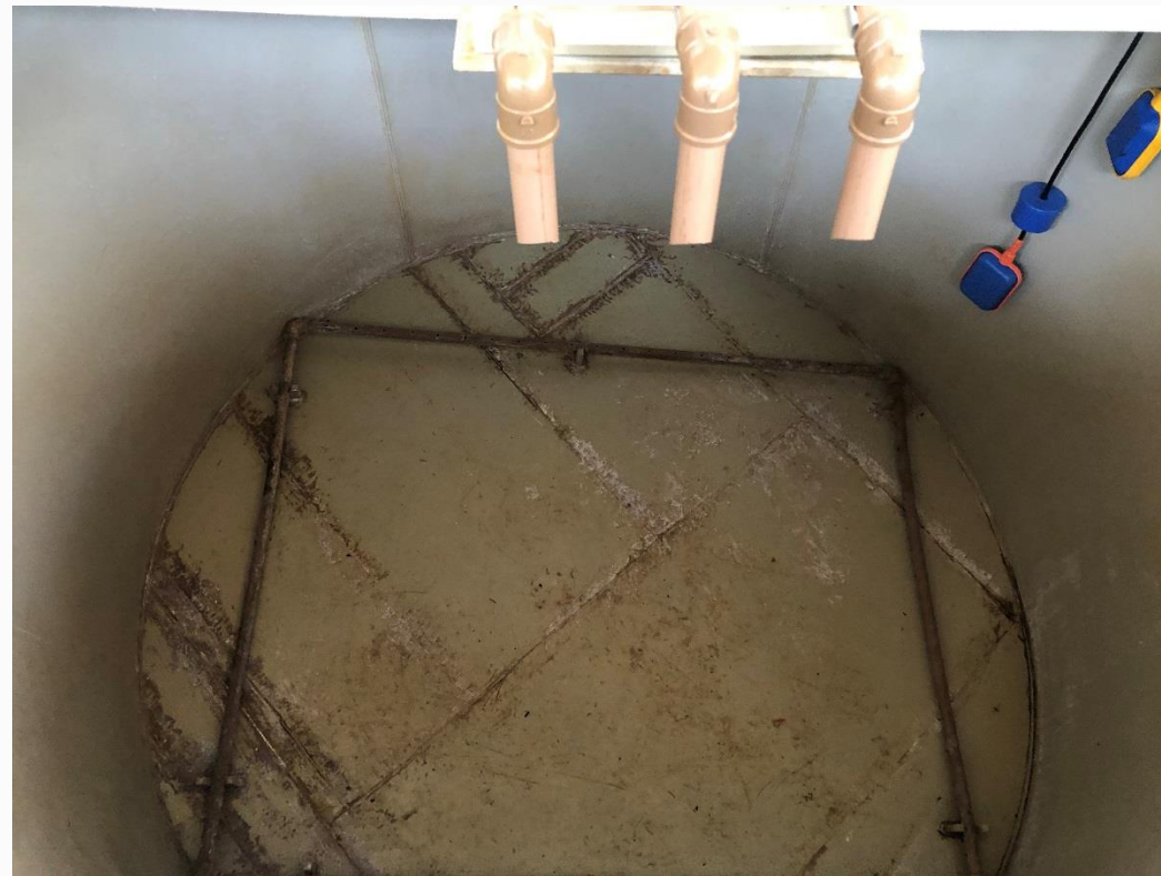
APÓS OS TRABALHOS
