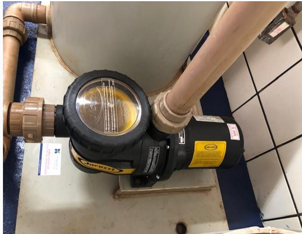
APÓS OS TRABALHOS
