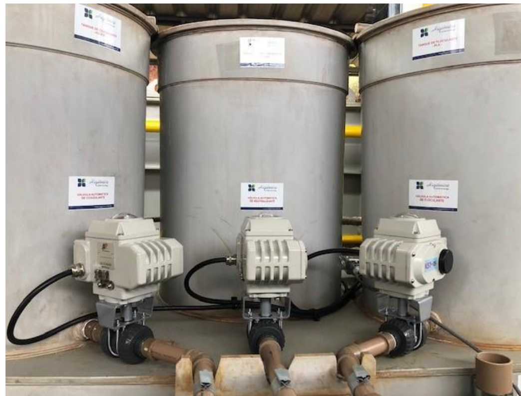
APÓS OS TRABALHOS
