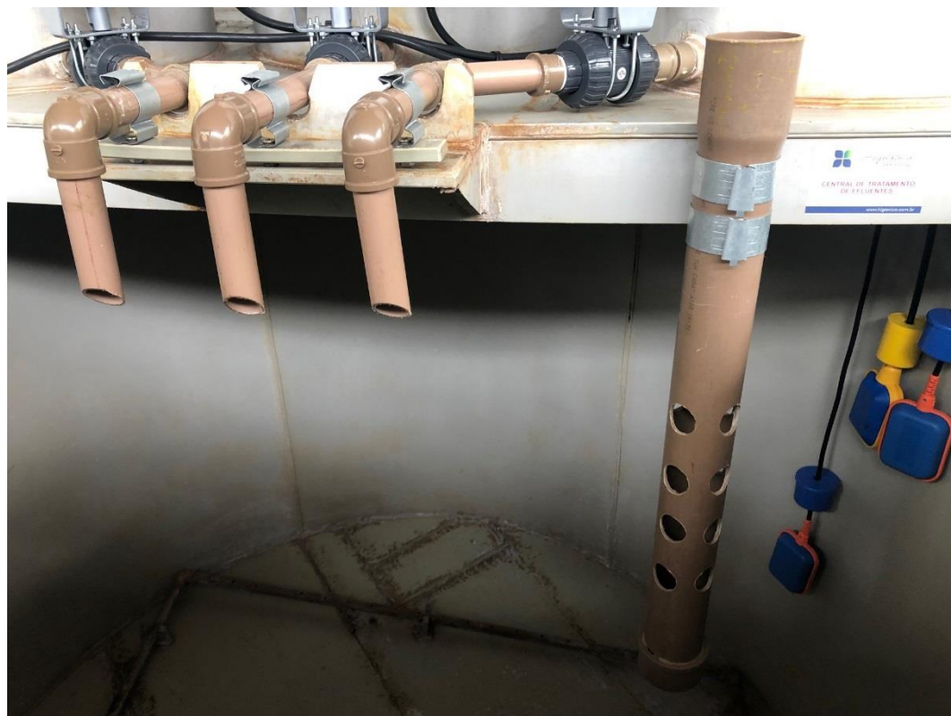
BÓIAS DE NÍVEL MÁXIMO, MÍNIMO E DESLIGAMENTO DA BOMBA CENTRÍFUGA
